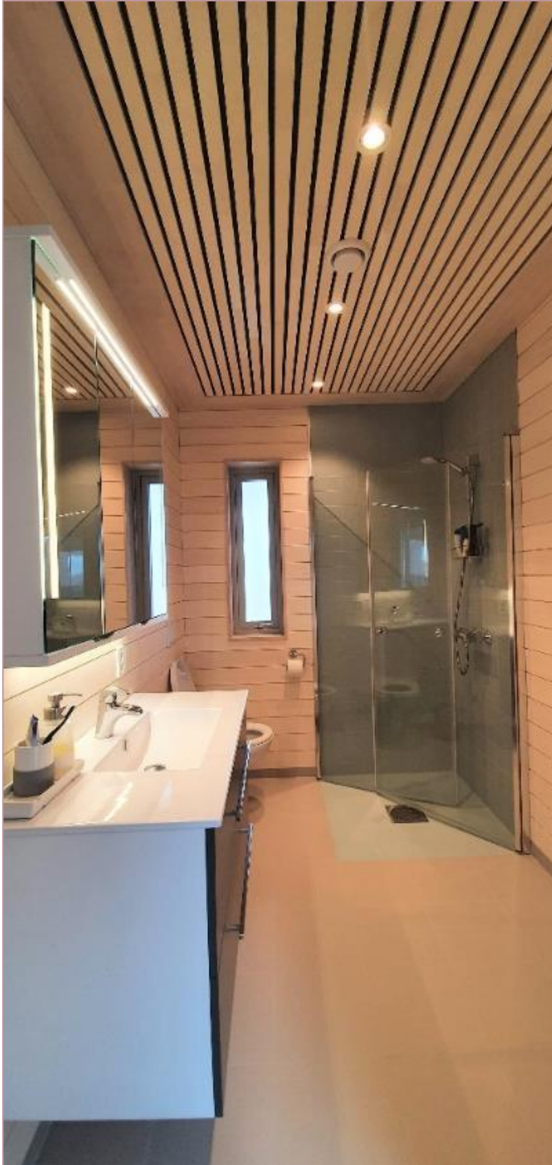
Fig 96 (a) Bad med aspegger/tak og fliser på golv og dusjvegg. Byrknes 10.september 2021
